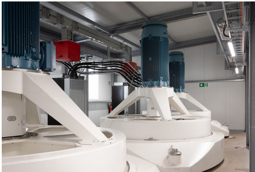
Figura 4 Volantes de inercia de almacenamiento de energía de S4 Energy (Holanda)
