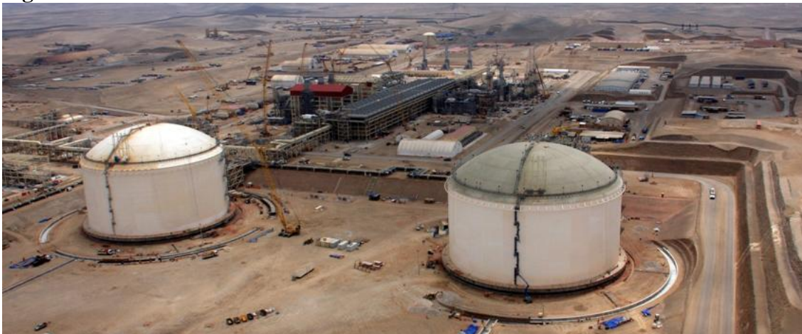
Figura N° 8.6. Vista Panorámica de la Construcción de la Planta de Licuefacción
