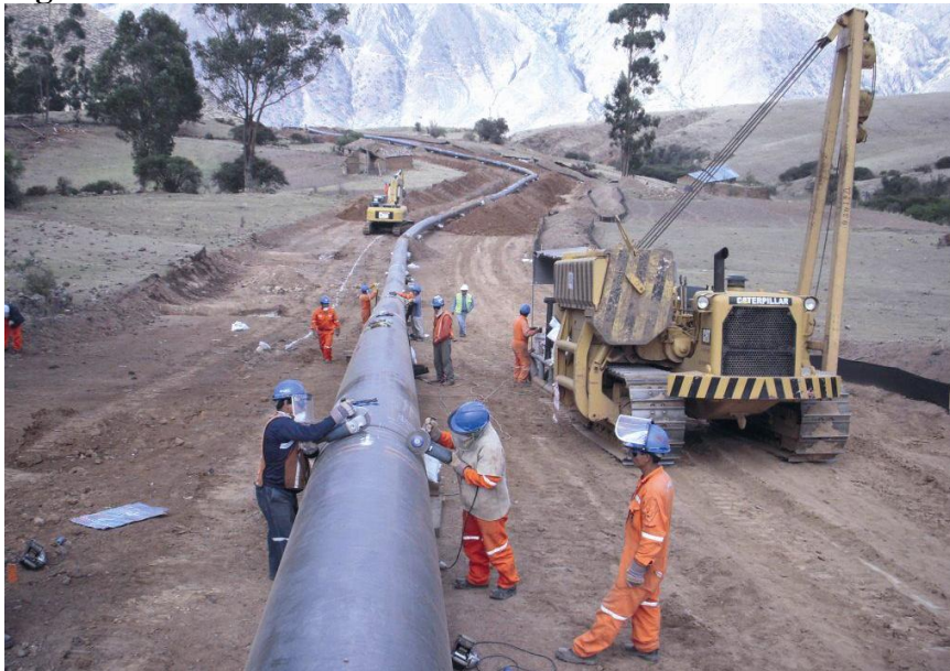
Figura N° 8.8. Vista de la Construcción del Gaseoducto de Perú LNG
