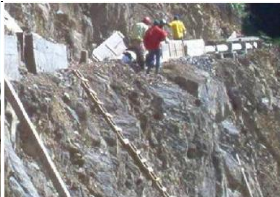
Ilustración XXXII Manejo de material hacia tubería de conducción
