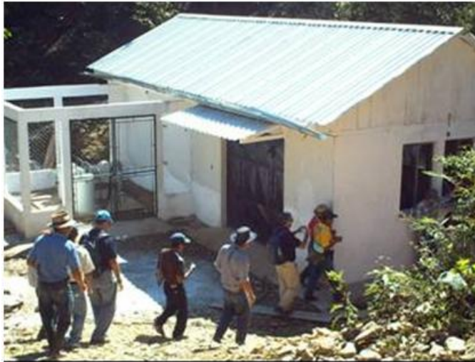
Ilustración XVI CASA DE MAQUINAS
