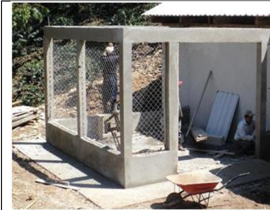
Ilustración XXIX cuarto de transformadores
