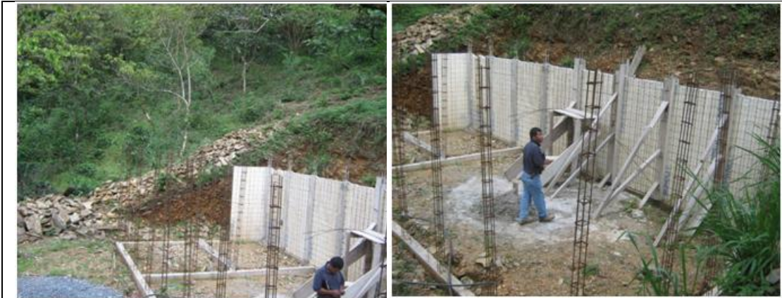
Casa de maquinas
