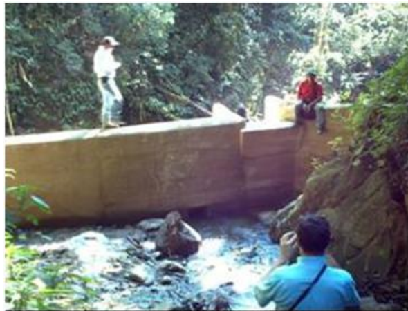
Ilustración VII Bocatoma
