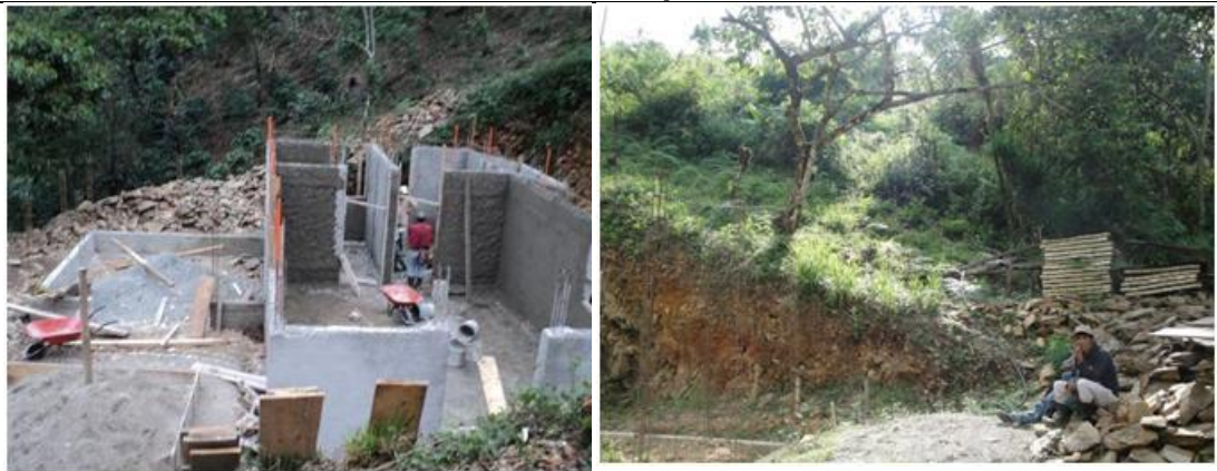
Casa de maquinas
