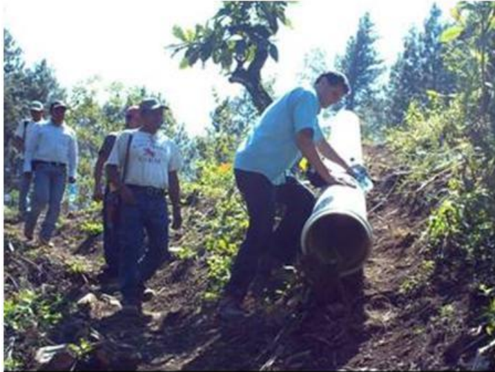
Ilustración XII Tubería de presión
