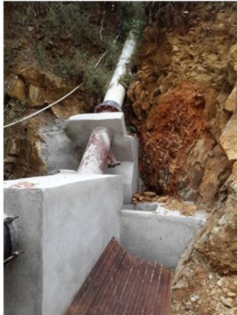
Ilustración LXXIII Casa de máquinas
