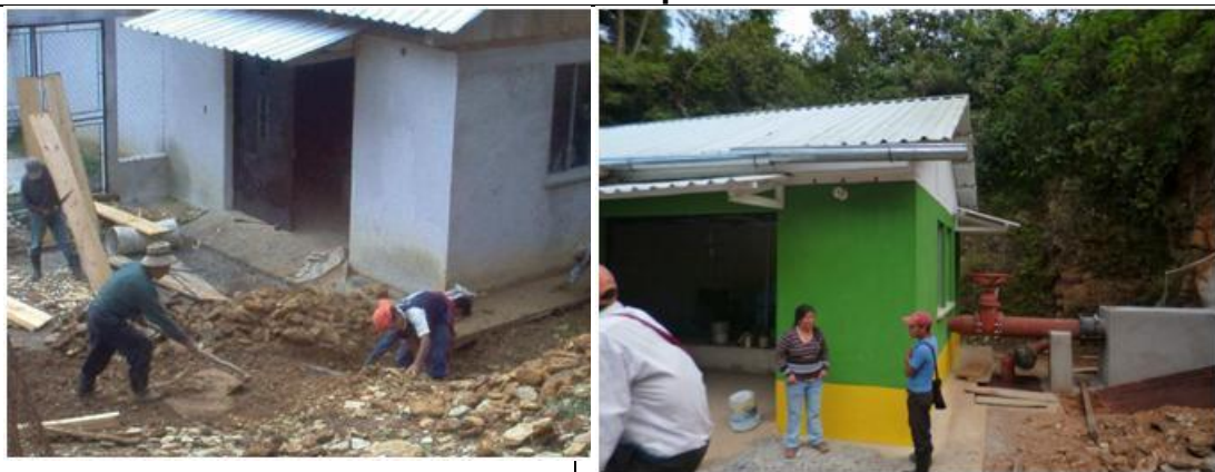
Ilustración XXVIII CASA DE MAQUINAS FASE FINAL
