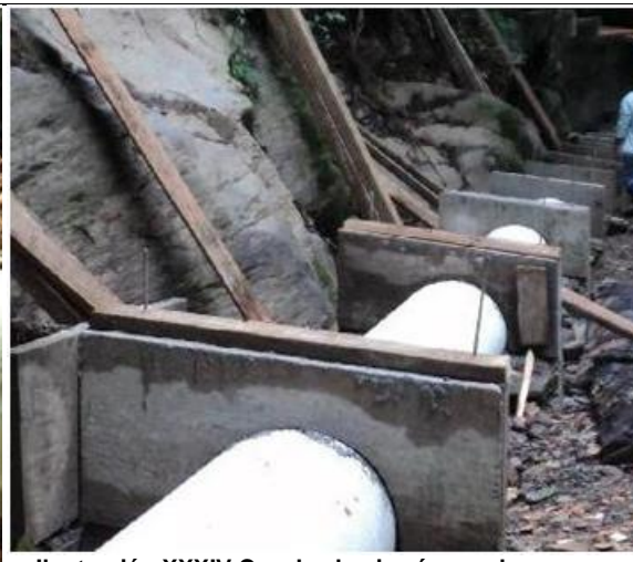
Ilustración XXXIV Canales hacia cámara de carga
