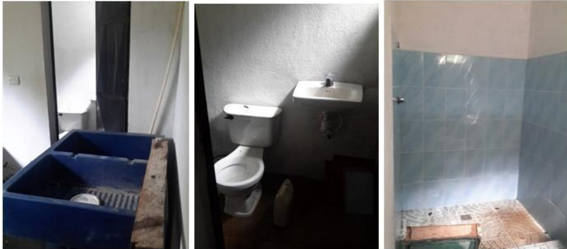
Ilustración LX Interior casa máquinas
