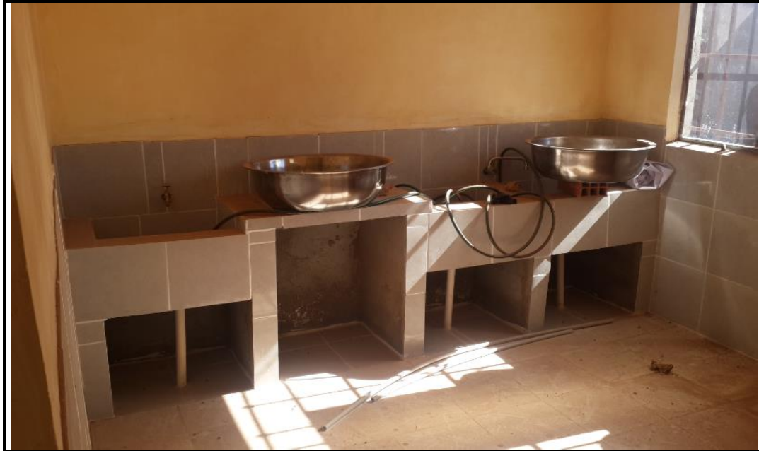
FOTO N° 3.3. Vista interior del matadero de Pozo Cavado donde se muestra las piletas de lavado y lavadores de acero inoxidable
