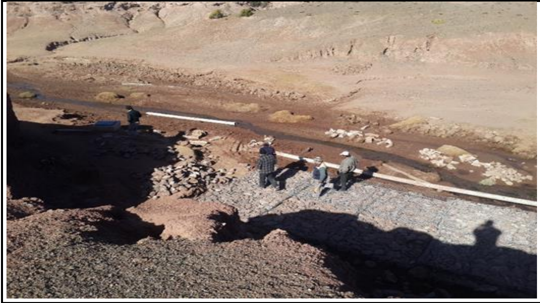
FOTO N° 5.1. Vista de la toma de agua del sistema de Micro Riego de Tambillo, donde se instalará el sistema de Generación Eléctrica Fotovoltaica para Bombeo de Agua
