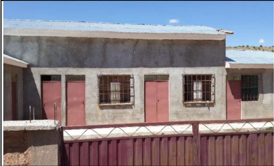
FOTO N° 3.1. Vista frontal actual de la fachada de edificio construido para el matadero de Pozo Cavado
